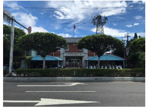
圖 2-4-3 重新橋頭的二重派出所正是位於二重埔
