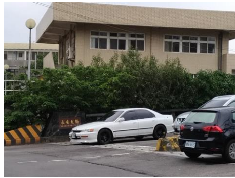
永安大橋現況:環堤大道出入口端
