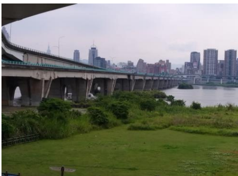
中興橋現況：由三重區環河南路河堤上方取景
