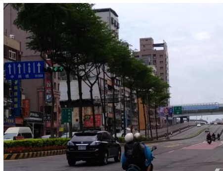
中興橋三重端：三重區成功路出入口
