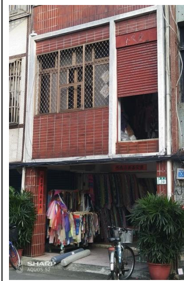
圖 4-1-16 二樓會增設鐵門，可於裝卸貨時直接從 2 樓往下搬，也是一大特色
