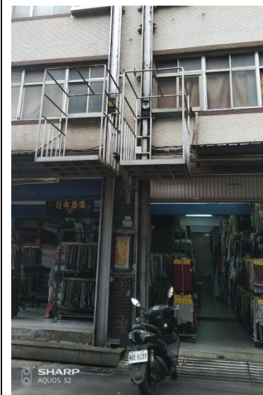
圖 4-1-17 後來改成在屋外加裝電動貨梯
